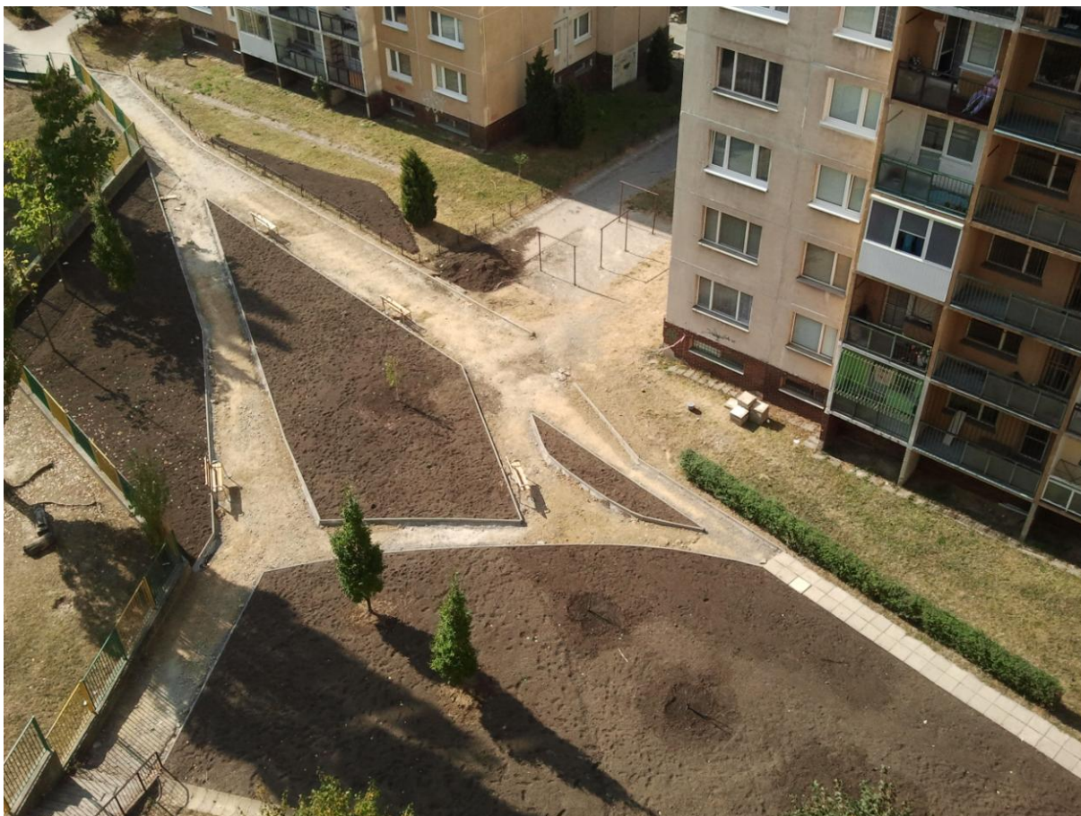
Výstavba parku Juhoslovanská.
