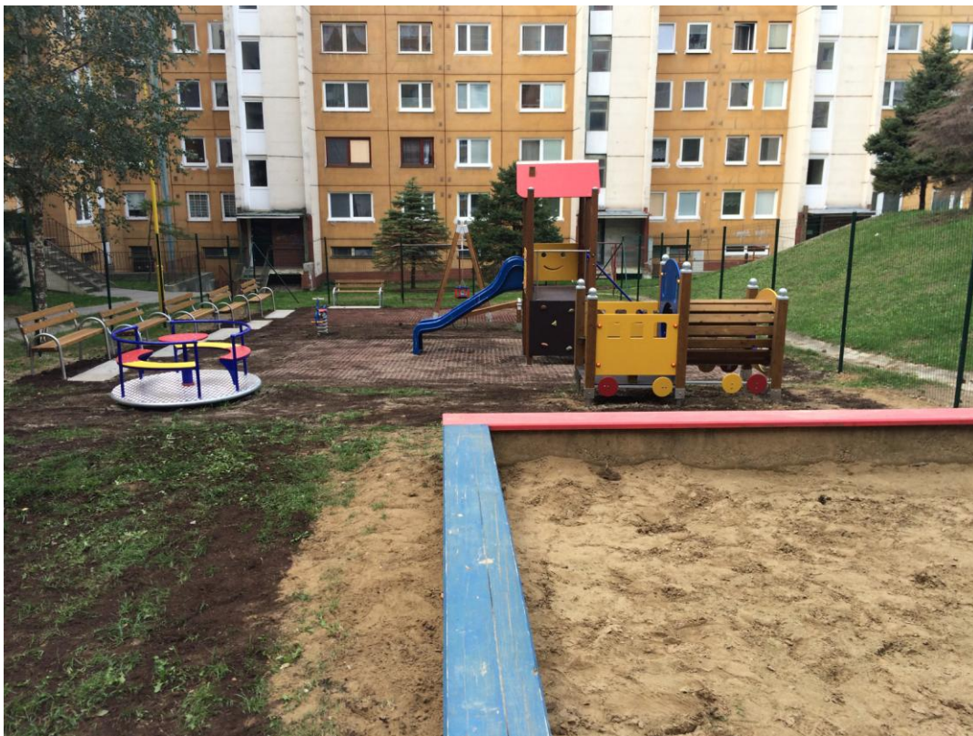
Výstavba detského areálu v dvore Pekinská.
